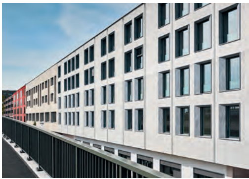
Variierende Fenstergewände beleben die Fassaden.
