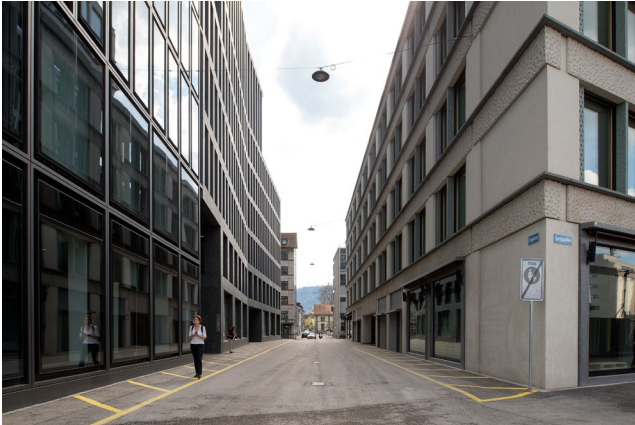
Grosse, parallele Fassaden verstärken den Schall. Harte Materialien und wenig Formenvielfalt ergeben einen monotonen Klangraum. Bild: Baugeschichtliches Archiv, Juliet Haller
