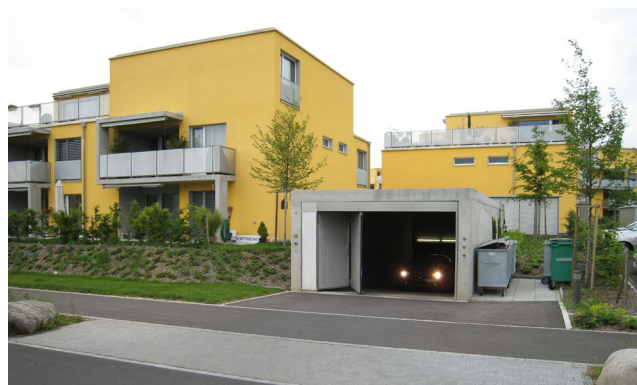
Abb. 3: Die von den Wohnräumen abgewandte und eingehaute Einfahrt nahe der Strasse ist ein gutes Beispiel zur Lärmreduktion. Bild: FALS
