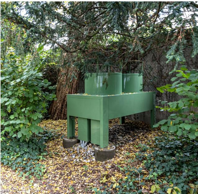
Unauffällig: Unter Büschen und Bäumen ist dieser Tischverdampfer an der Mauer eines Privatgartens gut versteckt. Er gehört zu einer Split-Anlage für sechs Wohnungen.
