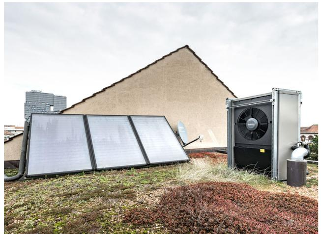
Platzsparend: Luft-Wasser-Wärmepumpe auf einem Flachdach im dichten Basler Gundeldingerquartier. Die Immissionen an den nächstliegenden Fenstern müssen bei dieser Aufstellungsart sorgfältig überprüft werden.
